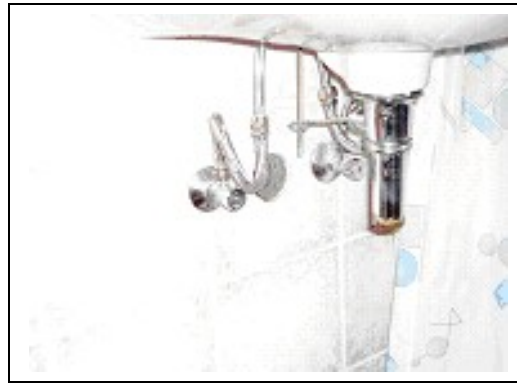
Ursache: Falsch angeschlossenes Abwasserrohr
