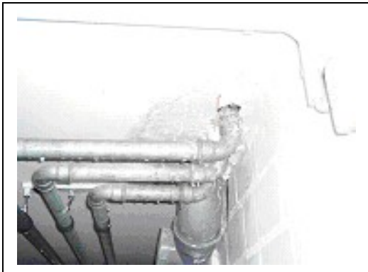
Wasser läuft durch die Deckenaussparungen
